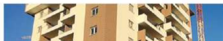
La torre 1, in primo piano. Al piano terra gli spazi per l'asilo nido
